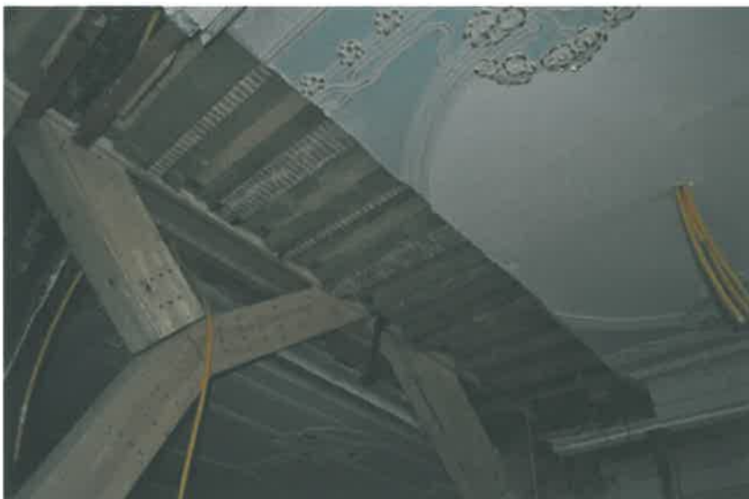
Die ursprünglichen Decken werden wieder hergestellt.
