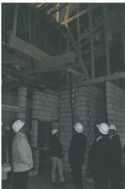
Die Arbeiten im Hotel Paxmontana gehen voran.
