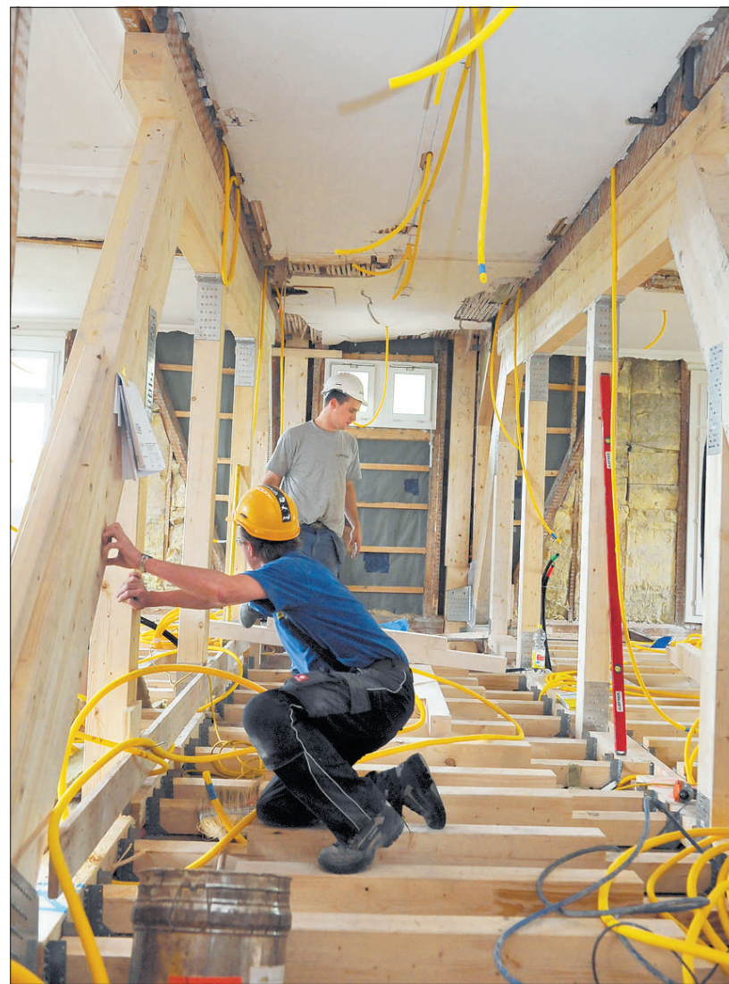
Bald werden noch mehr Handwerker im «Paxmontana» arbeiten. Bild Corinne Glanzmann
