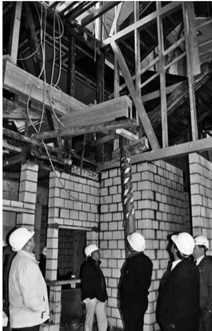
Die Arbeiten im Hotel Paxmontana gehen voran. FOTO: BIRGIT SCHEIDEGGER
